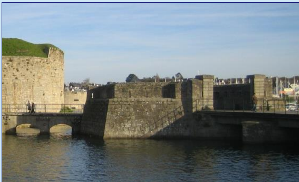
Le ravelin et le pont d'entrée ©Agence De Ponthaud
