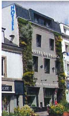
Exemple d'enseigne perpendiculaire et d'enseignes à plat en lettres découpées à l'étage, y compris sur mur aveugle
