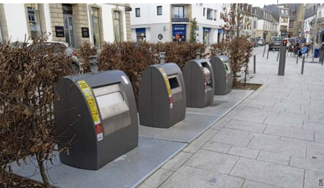
Site de colonnes enterrées de la place Général-De-Gaulle
